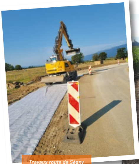
Travaux route de Séigny
