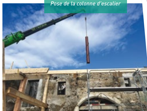
Pose de la colonne d'escalier
